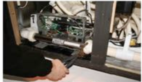
Verbindung vom Ein- und Auslass zur Steuereinheit trennen.
