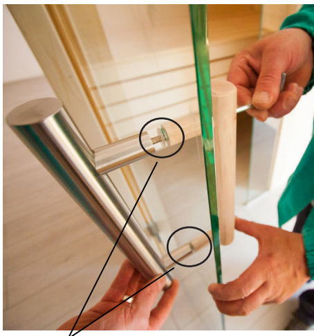
Applicare rondelle di plastica nelle maniglie Nirosta
