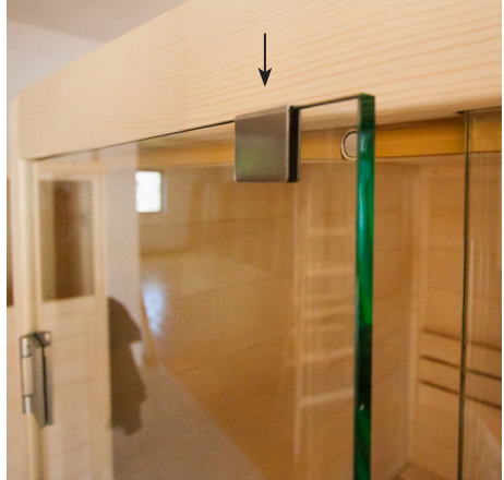
Pose des rondelles de calage en plastique pour poignée inox
